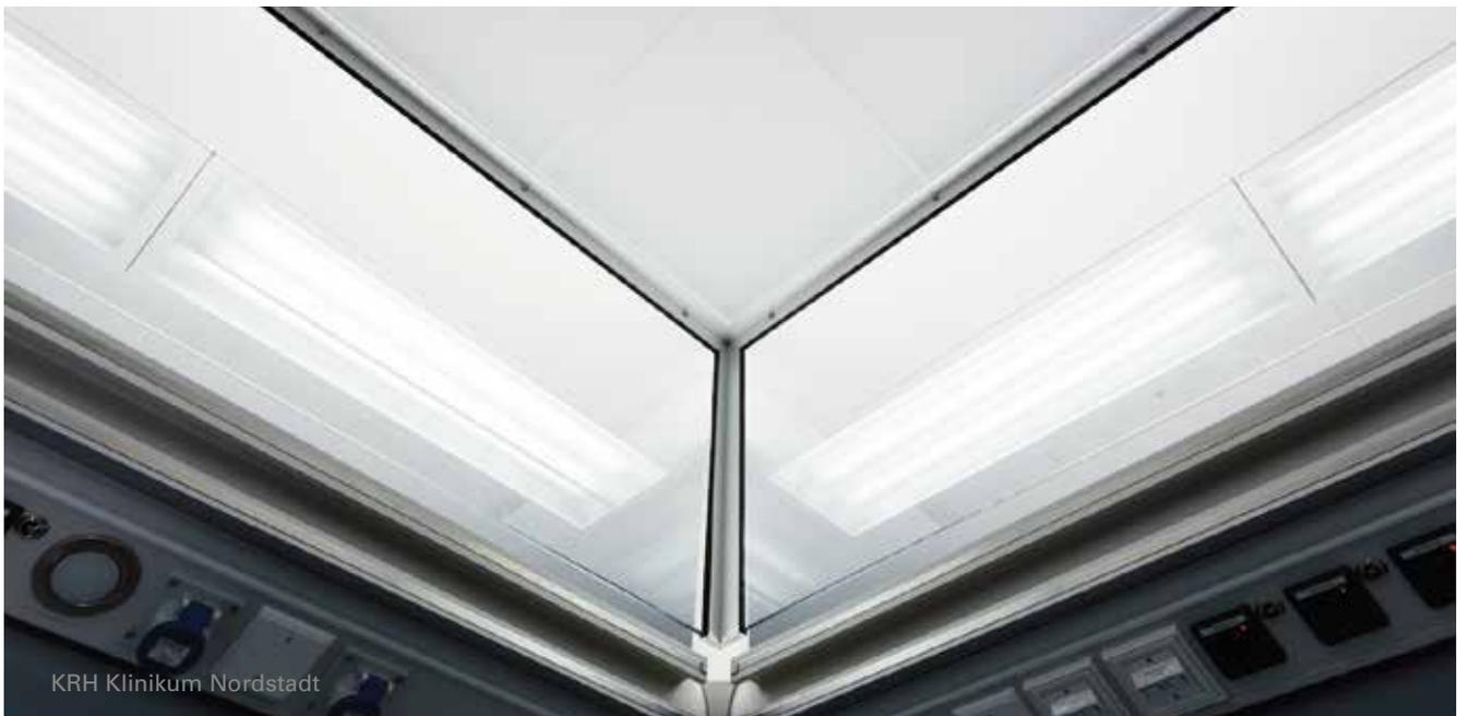
OP-Deckensystem Clip mit umlaufendem Lichtkranz und Anbindung an TAV-Feld.
