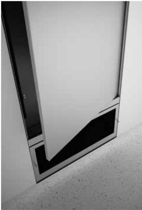
Revisionierbarer Abluftschacht in Kombination mit Lüftungsgitter Typ fibresept.
